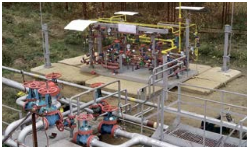
Рис. 6. Общий вид блока с экспериментальными образцами гидроциклонов, подключенных к УП ЖУВ Fig. 6. General view of the block with experimental samples of hydrocyclones connected to the the installation for the preparation of liquid hydrocarbons
